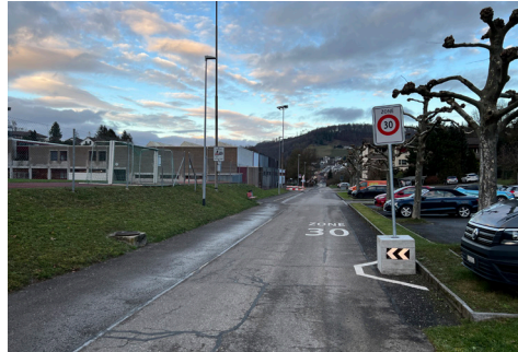
Signal auf Betonquader mit Zone-30-Markierung an der Lochstrasse in Eningen Foto: V. Müller
