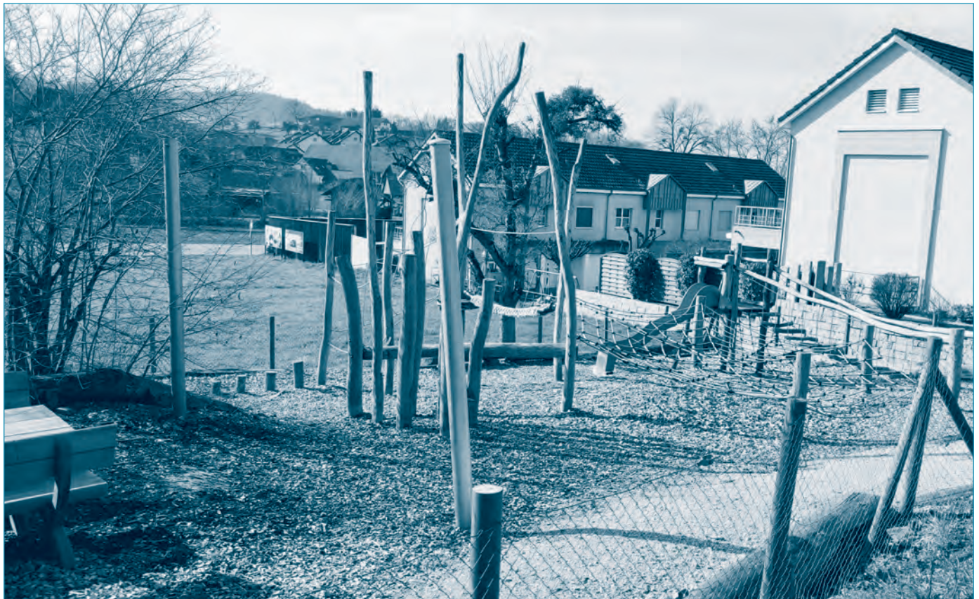
Sanierung des Spielplatzes Bodenstrasse.
