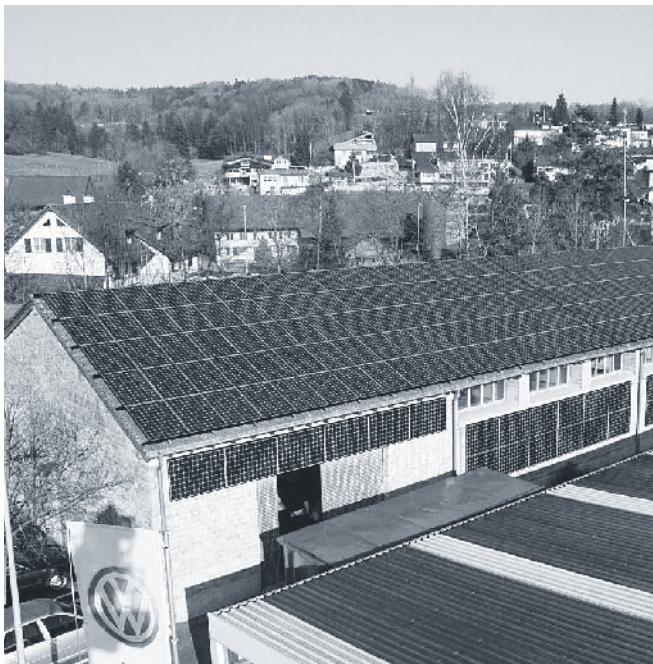
Dach des Werkhofes Lengnau
